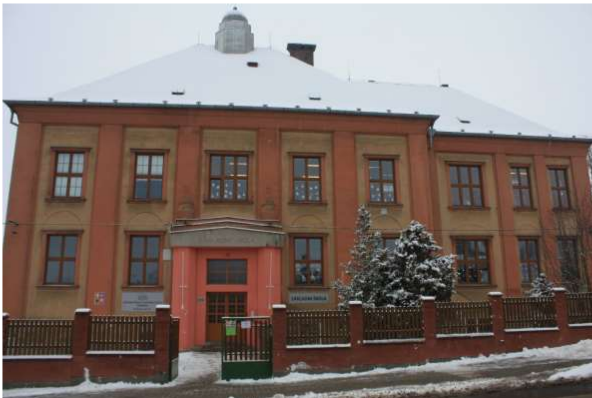
Budova základní školy; Chotíkov 455
